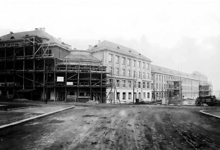
Obr. 4. Zadní trakt rozestavěné první budovy podle Engelova projektu (dnes budova A, VŠCHT Praha)
