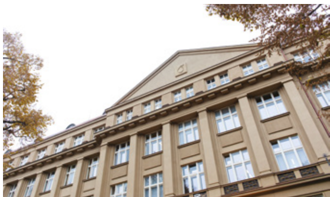
Nová fasáda budovy B.
